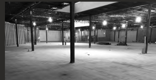
Pre-installation slab evaluation / Évaluation de la dalle
