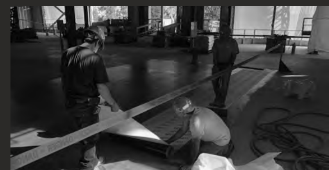
Peel + Stick Crack Isolation Sheet Membrane installation / Installation de la Membrane de Pontage de Fissures TEC
